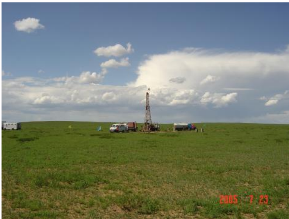
内蒙古二连盆地砂岩型铀矿勘查现场一角
