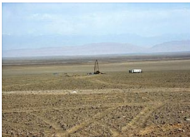
内蒙古鄂尔多斯铀矿勘查现场
