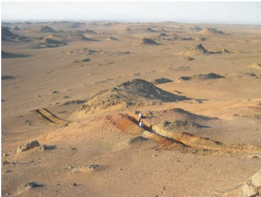
新疆哈密卡拉塔格铜矿探槽施工
