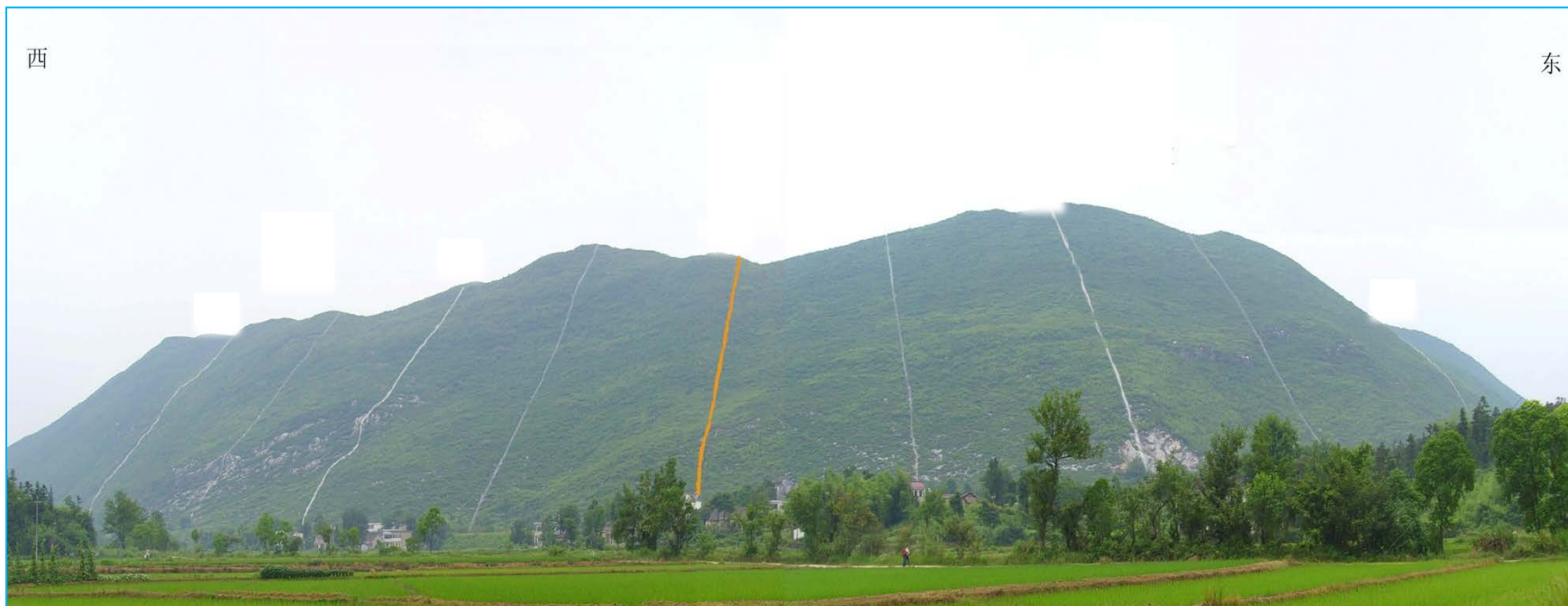
池州神山水泥用灰岩矿野外全景图
